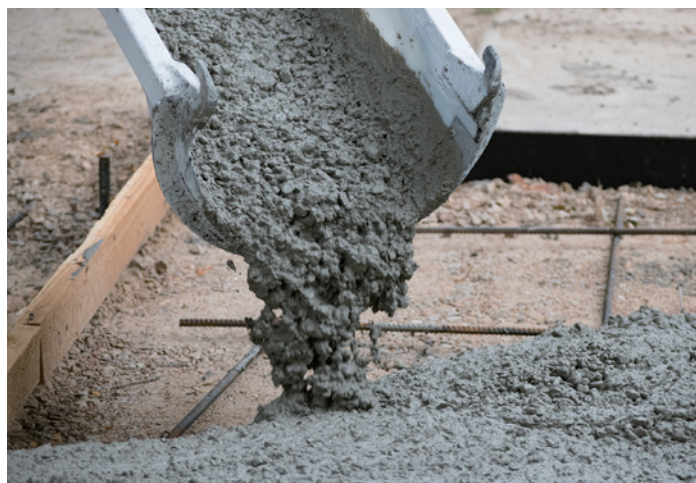
圖 14、控制性低強度回填材料 (CLSM) 示意圖
